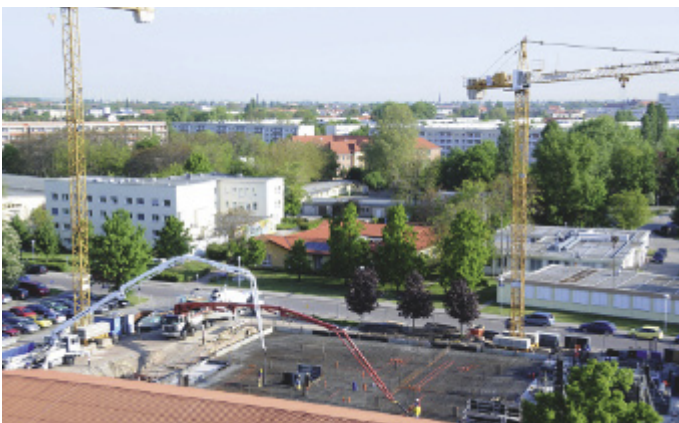
Anfang Mai wurde die Fundamentplatte betoniert. (Foto: Elke Lindner)
