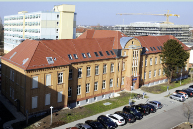
1 Das Haus 9 nach Abschluss der Fassadensanierung, rechts dahinter der DZNE-Rohbau
